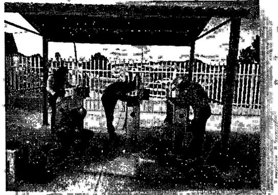
En el mes de noviembre en plantel EMSaD Paredón. Se da mantenimiento a los equipos de aire acondicionado, lavando compresores y evaporadores, así como la revisión de carga de gas a los equipos
